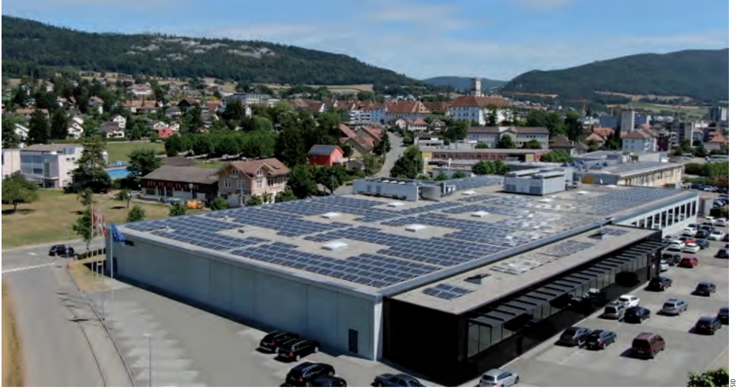
La centrale photovoltaïque installée chez TURCK duotech SA a été mise en service le 15 janvier 2020. Elle produira quelque 600'000 kWh par an.
