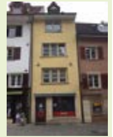
Une façade rénovée en Vieille Ville.
