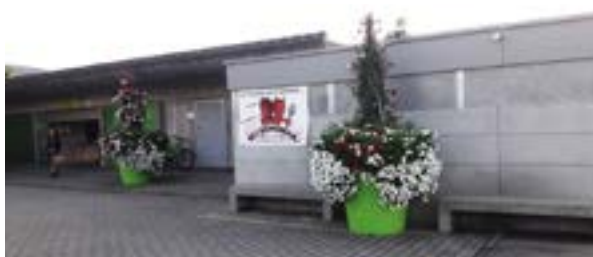
Piscine du Centre sportif.
